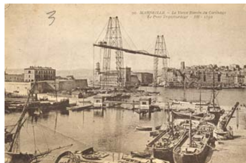
Pont transbordeur et bassin du carénage Estienne d'Orves
